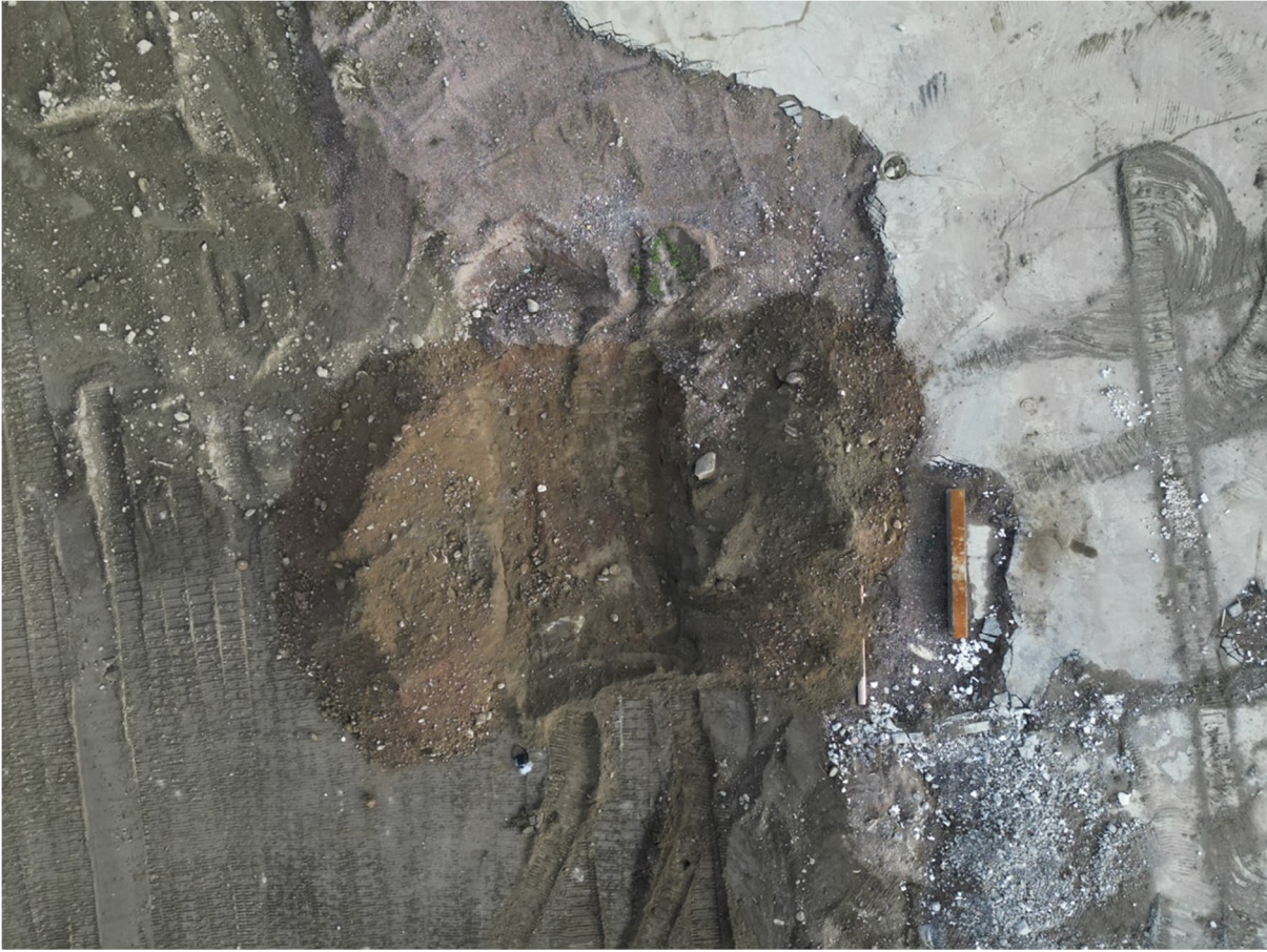
Kuva 7. Vanhan öljysäiliön kaivanto, kaivetut maa-ainekset hyödynnettiin täytöissä
