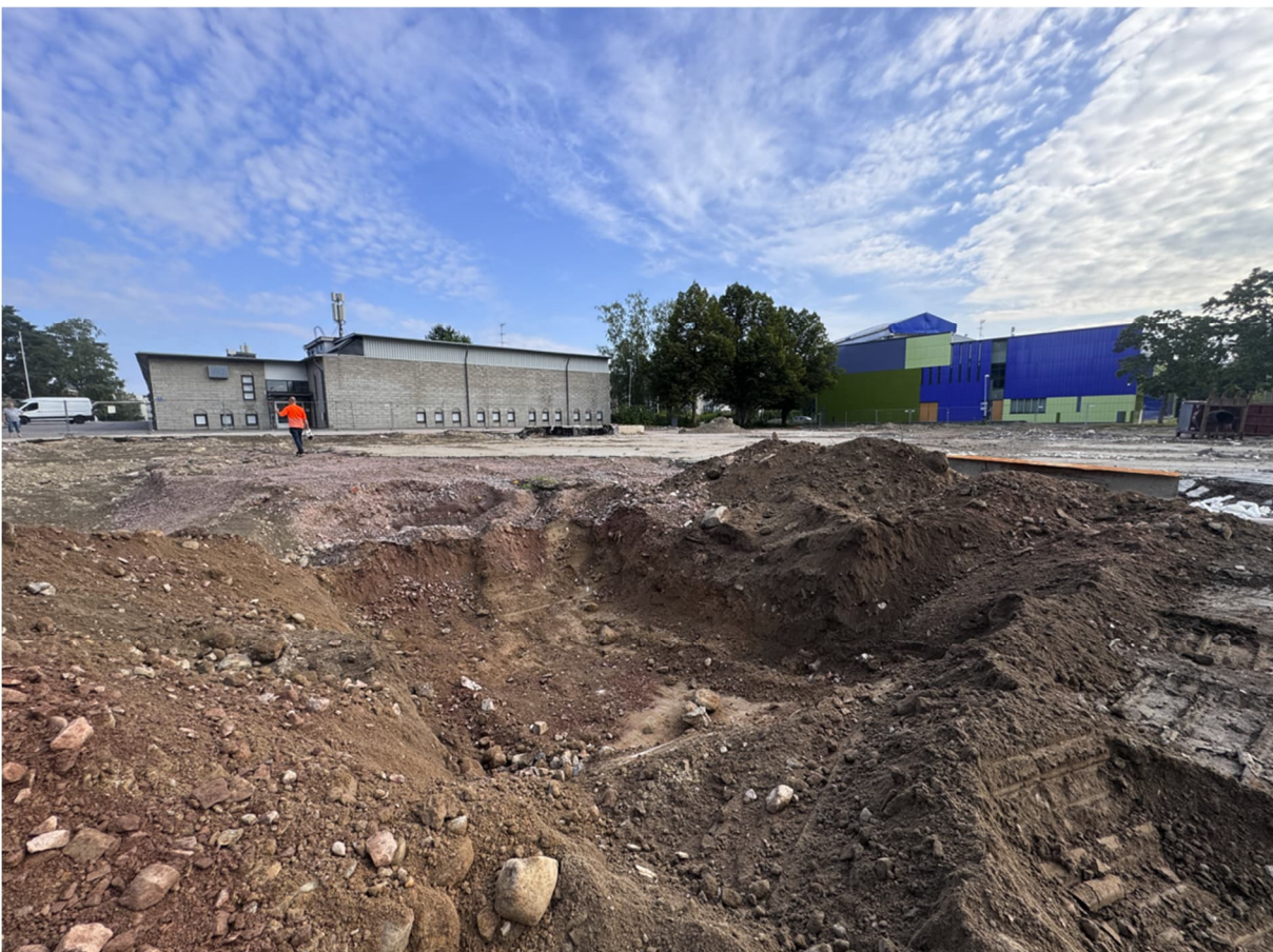
Kuva 4. Vanhan öljysäiliön kaivanto
