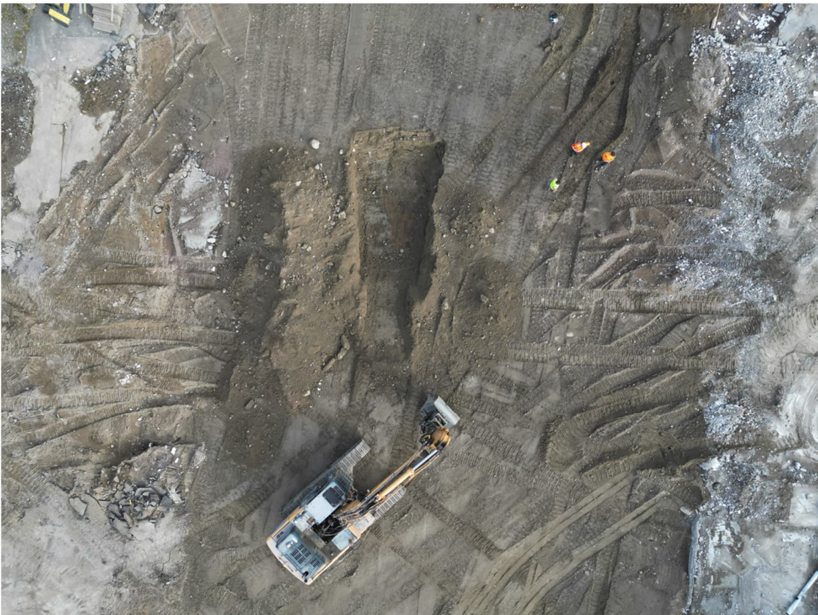
Kuva 6. Pannuhuoneen kaivanto, kaivetut maa-ainekset hyödynnettiin täytöissä
